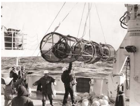
Фото 4. Рабочий момент постановки дрейфующей трёхэлементной комбинированной приёмной антенны в Тихом океане
